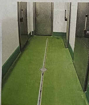
Im neuen Schlachthaus von Elviras Bauernladen läuft das Putzwasser über Schlitze ab.
